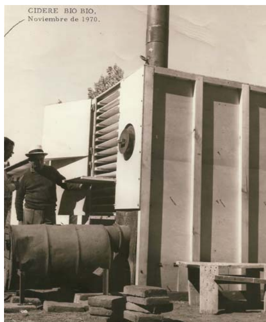
La primera instalación deshidratadora con tecnología de Cidere, puesta en operación en Pangal de Laja.
