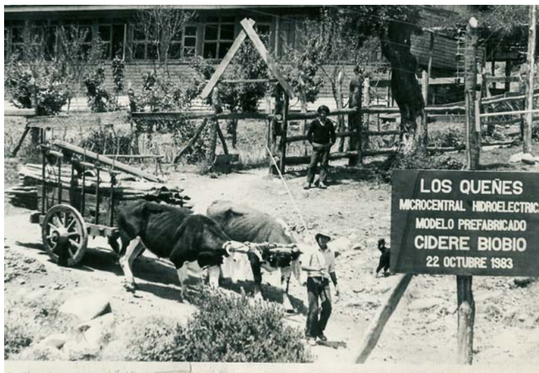
En el sector de Los Queñes, en Coihueco, la microcentral hidroeléctrica permitió generar electricidad para la escuela rural local.
