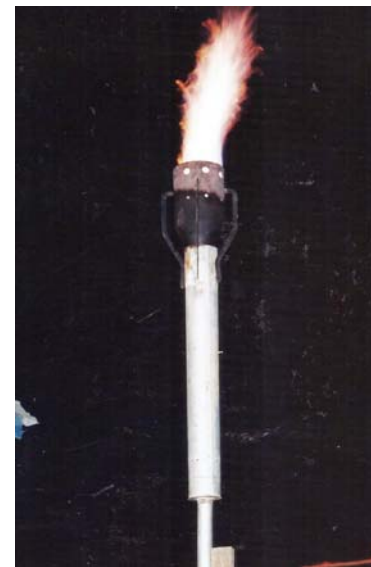
La antorcha de seguridad permitía quemar los gases contaminantes.
