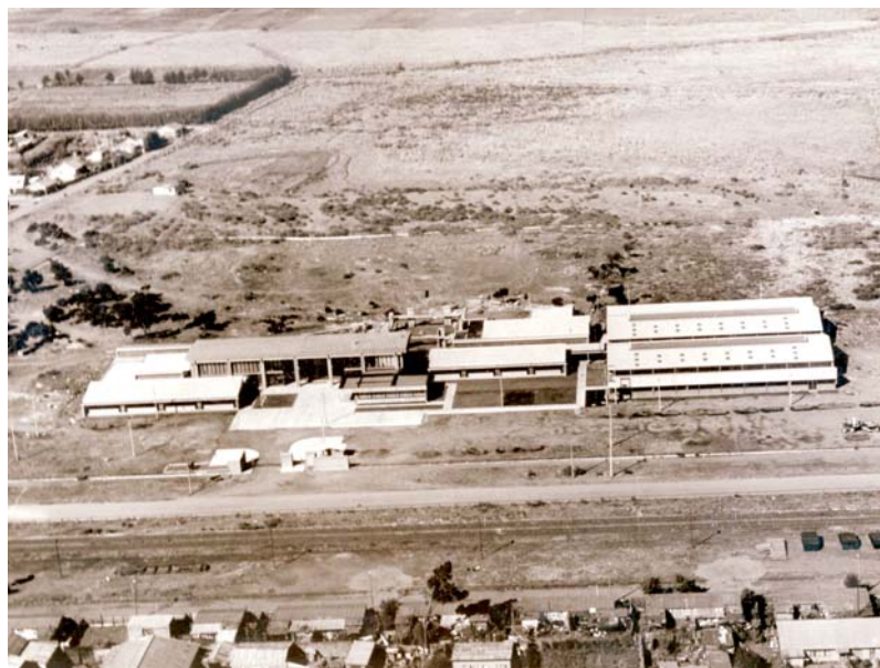
Vista aérea de la universidad durante su construcción.
