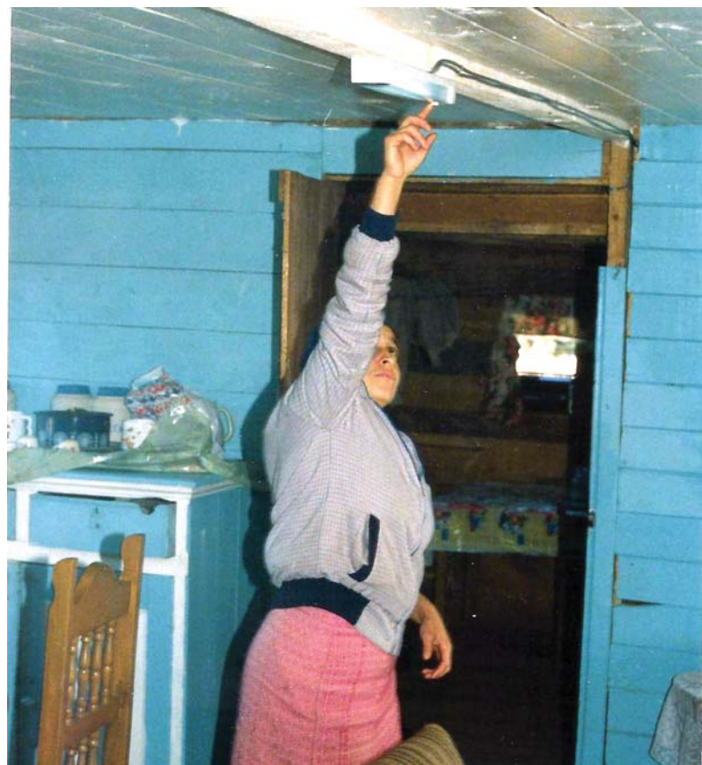
Una dueña de casa enciende la luz eléctrica de su hogar proveniente de los paneles solares.
