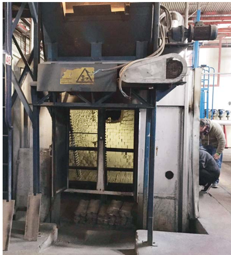
Al interior se pueden apreciar los ladrillos refractarios del horno.
