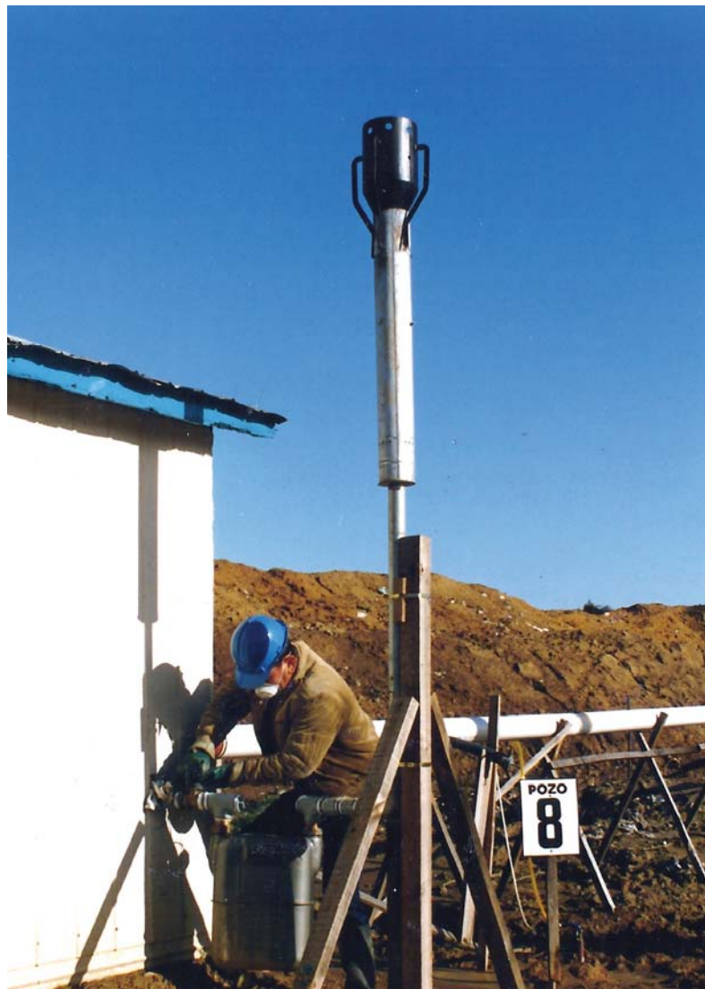
La instalación demostrativa se habilitó en el vertedero de Cosmito.
